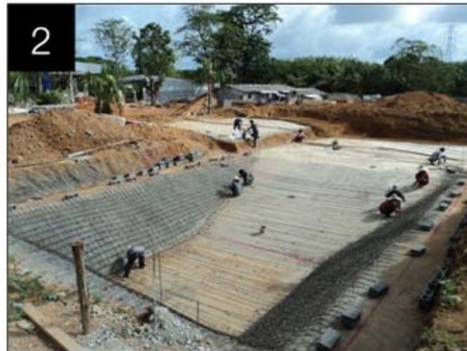
Reinforced Rebar Slab and Levelling Blocks เทเส้นพื้นสระ และวางเหล็กเส้น
