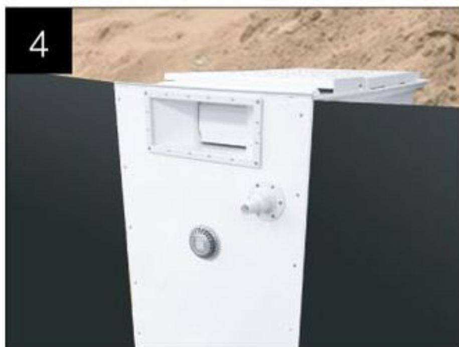
TE Filter Installation ติดตั้งเครื่องกรองอัจฉริยะ
