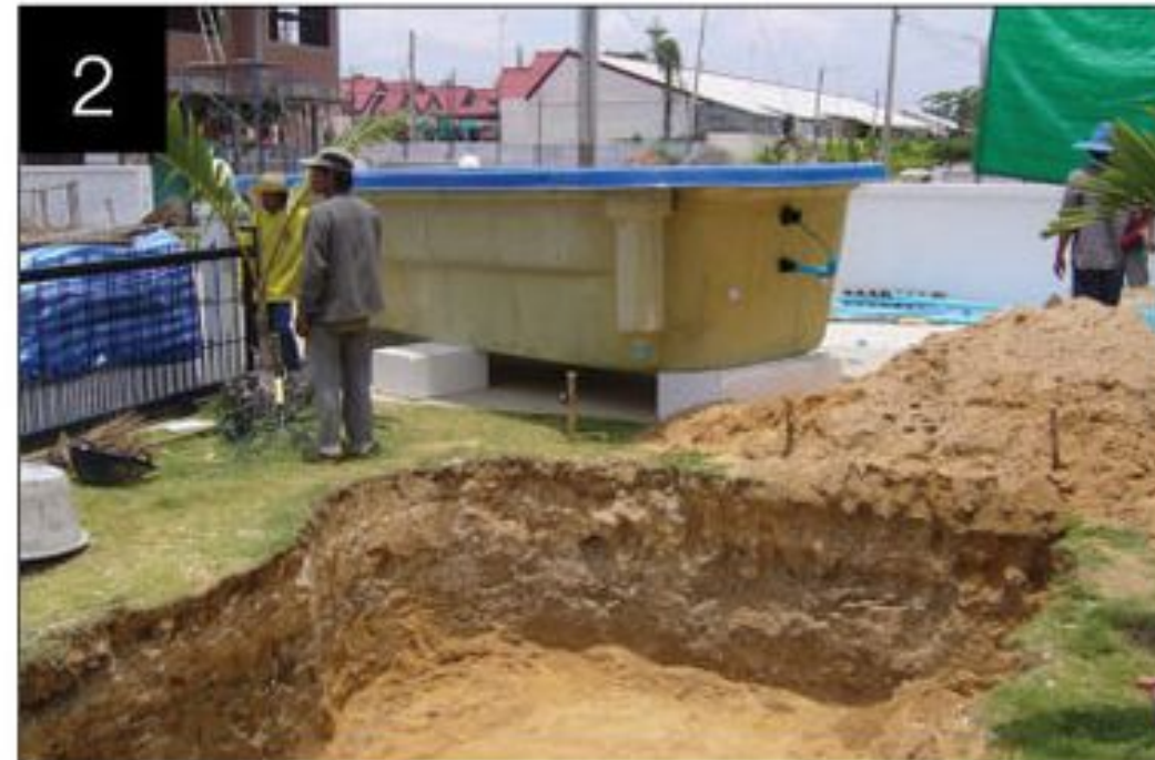
Ground Preparation and Excavation ขุดดินเตรียมพื้นที่ลงสระ
