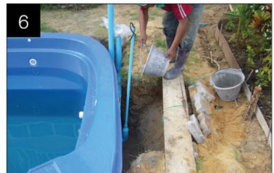
Begin filling with water and back filling งานถมยี่ดระดับสระ
