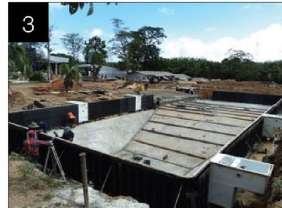
Assembly of Permanent iPanel เตรียมผนังสำเร็จตามแบบ และตั้งผนัง
