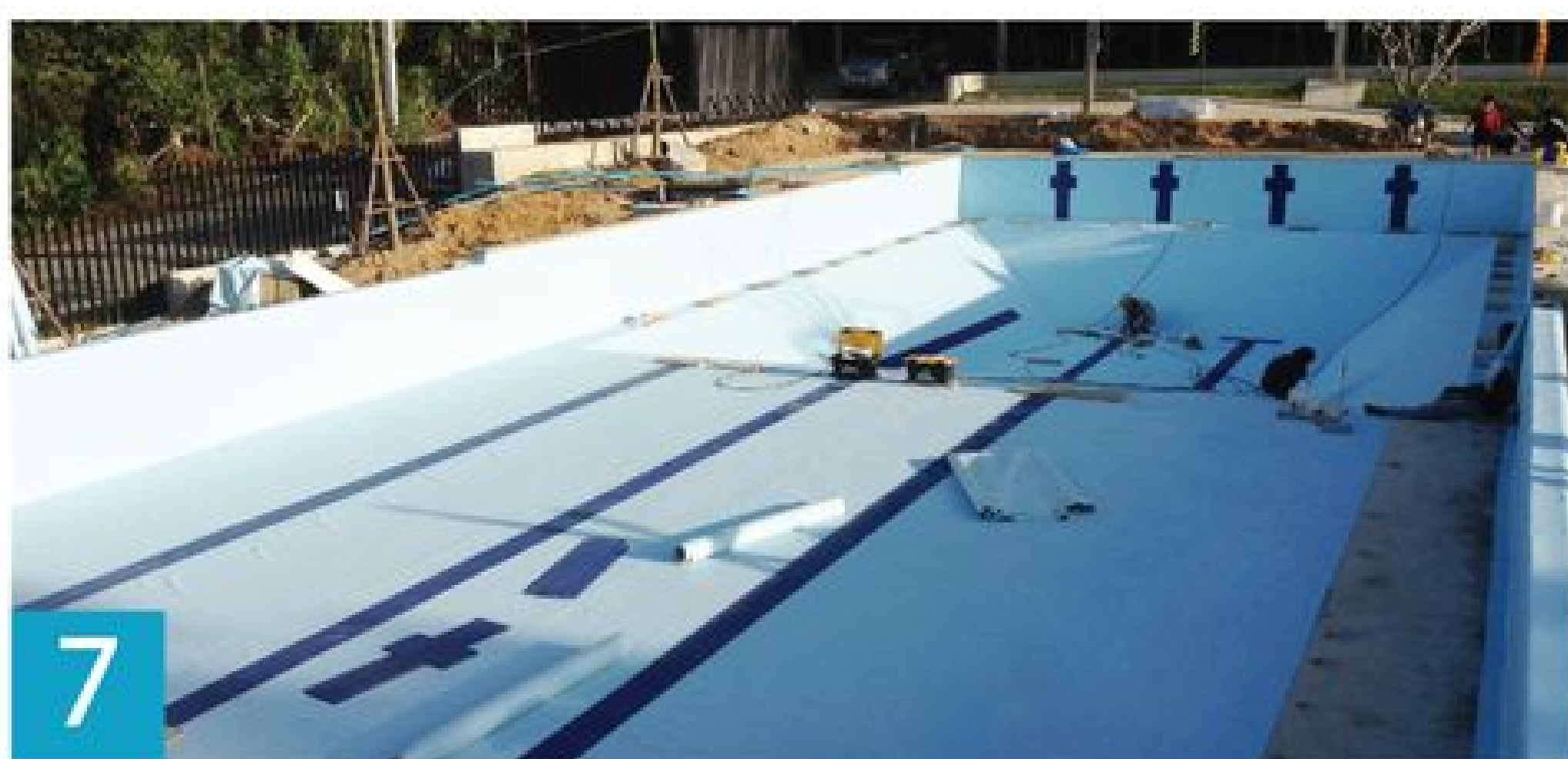
7 PVC lining complete ติดตั้งไลเนอร์ผนัง พื้น
