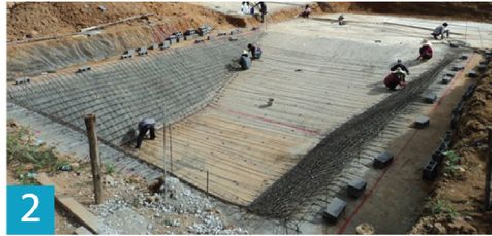
2 Reinforced Rebar Slab and Levelling Blocks เทเส้นพื้นสระ และวางเหล็กเส้น
