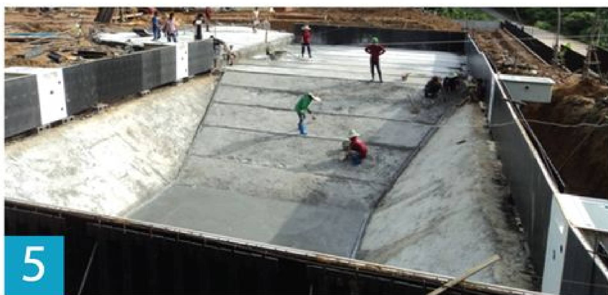
5 Pours concrete into pool slab and wall in a single process เทคอนกรีตและผนัง พร้อมกันเป็นงานชิ้นเดียว
