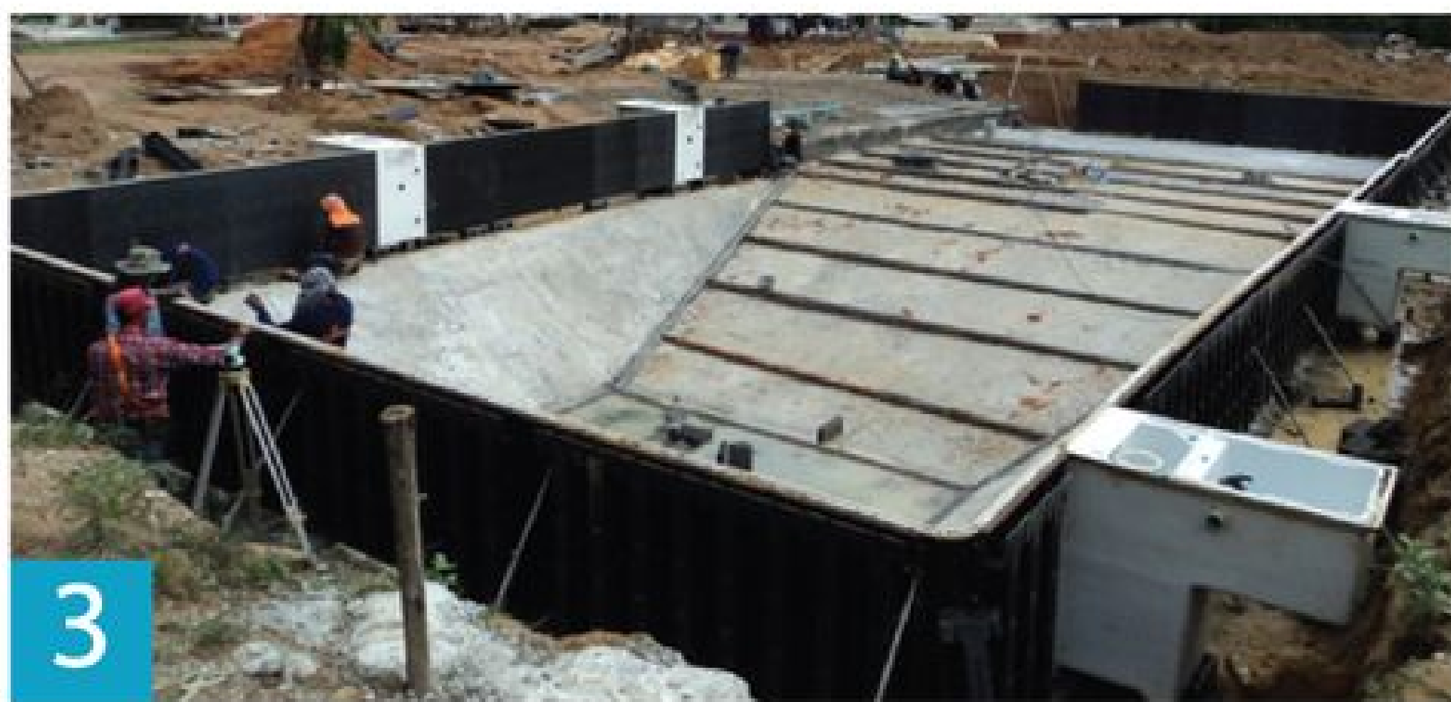
3 Assembly of Permanent iPanel เตรียมผนังสำเร็จตามแบบ และตั้งผนัง
