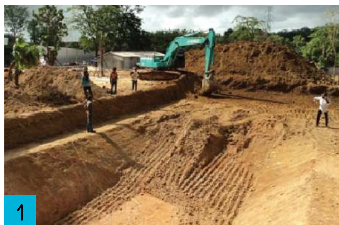
1 Layout and Excavation วางผัง และขุดดิน
