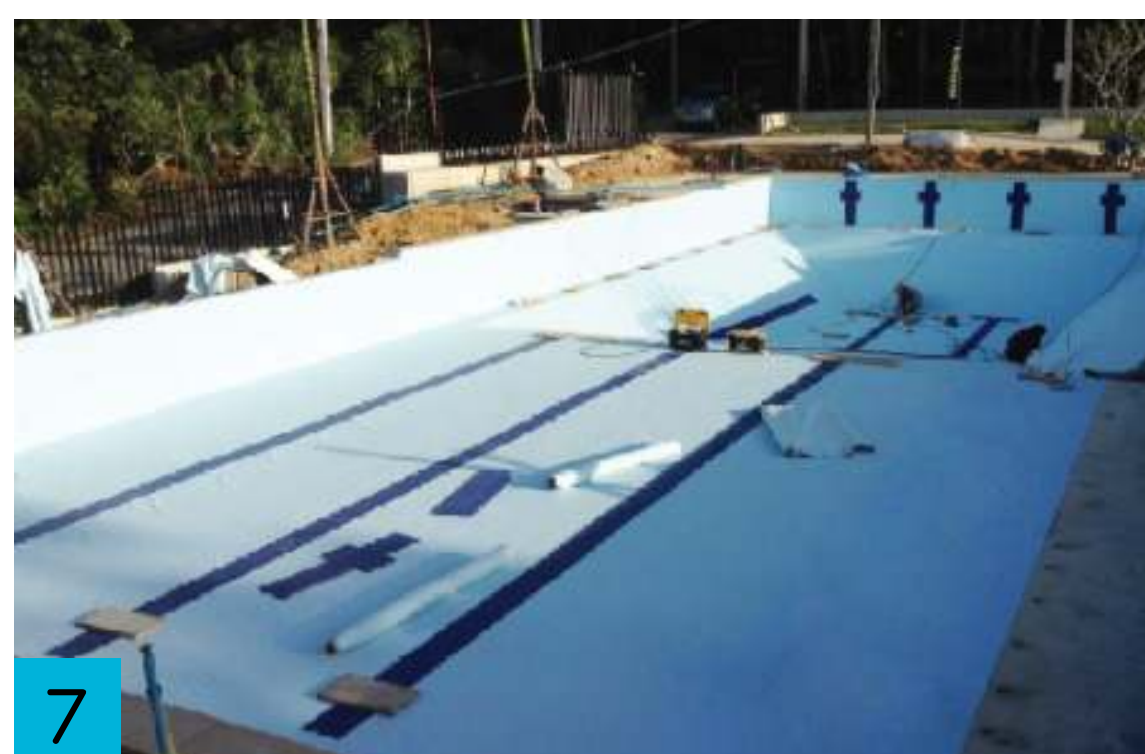
7 PVC lining complete ติดตั้งไลเนอร์ผนัง พื้น
