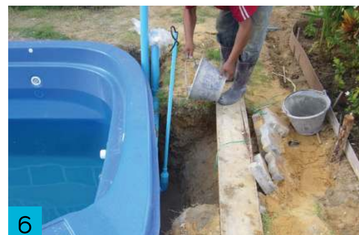
Begin filling with water and back filling งานถมยี่ดระดับสระ
