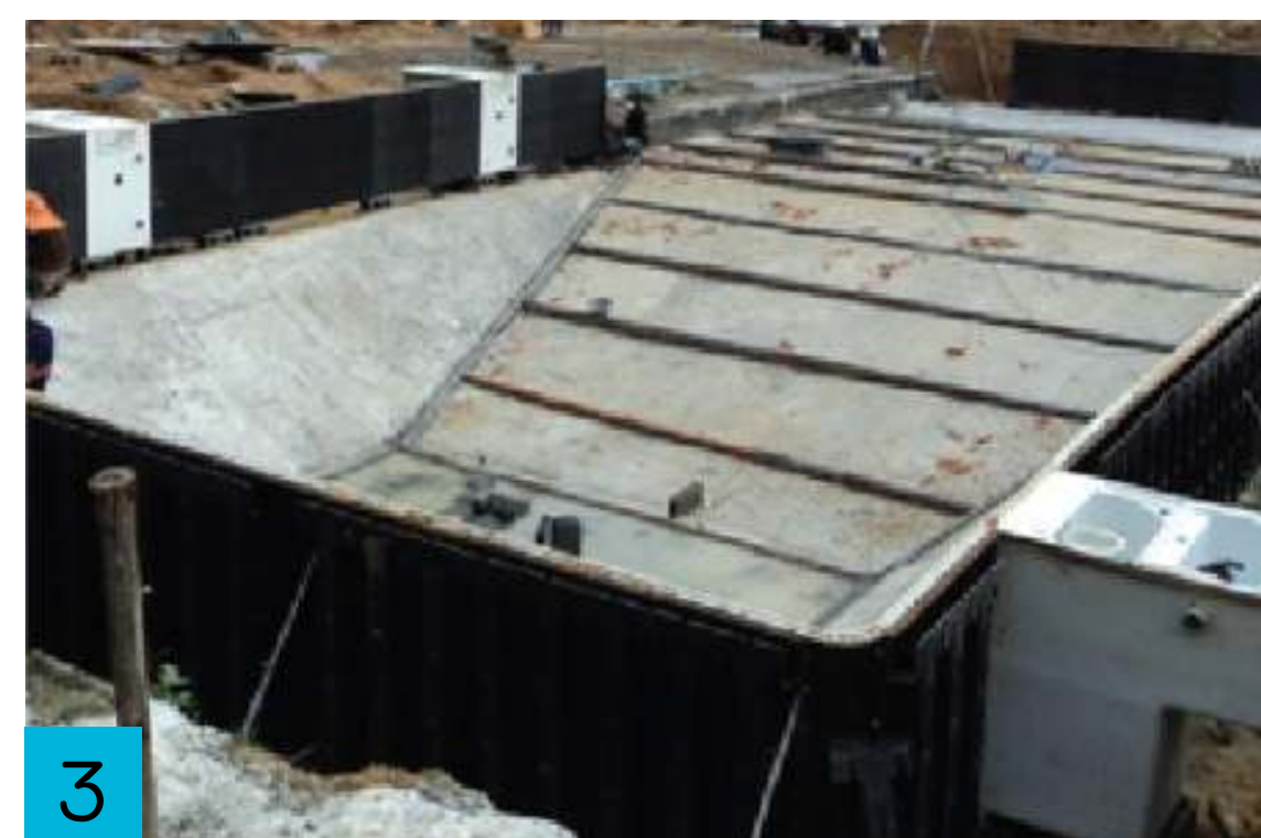
3 Assembly of Permanent iPanel เตรียมผนังสำเร็จตามแบบ และตั้งผนัง
