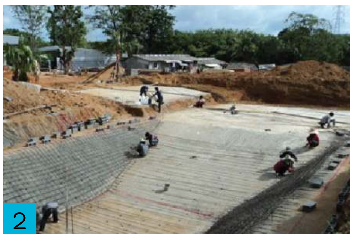
2 Reinforced Rebar Slab and Levelling Blocks เกลี่ยพื้นสระ และวางเหล็กเส้น
