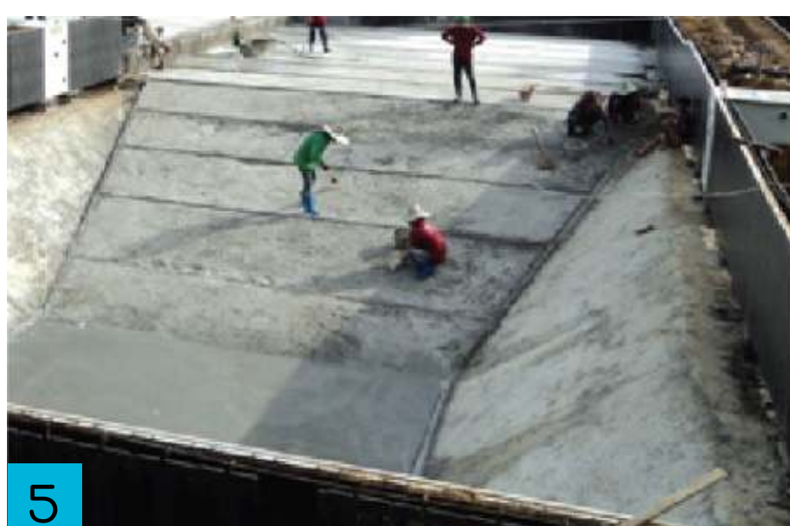
5 Pours concrete into pool slab and wall in a single process เทคอนกรีตและผนัง พร้อมกันเป็นงานชิ้นเดียว
