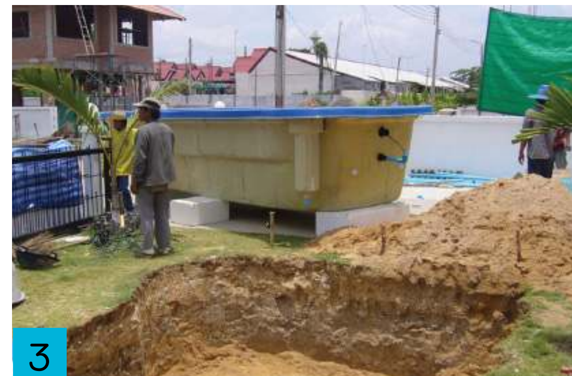
Hole Surface Preparation and Sand Bed การเตรียมหน้าดิน การปรับระดับ
